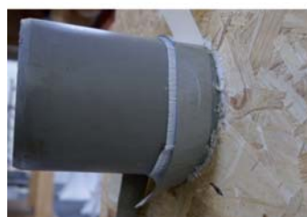
Zweites Silikonpapier entfernen
