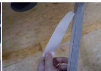
Entfernen der ersten Silikonpapierseite
