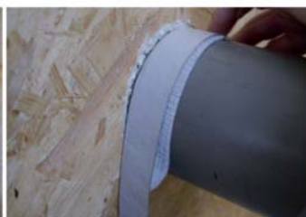
Anbringen des Klebebandes an der Durchdringung
