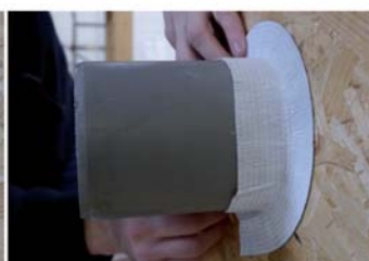
Anformen der zweiten Klebebandseite an den Untergrund
