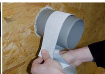
Abhängen auf Umfang der Durchdringung
